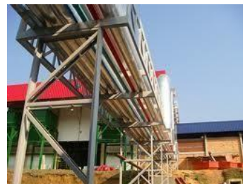
Obra realizada na AMBEV – Pirai - RJ
